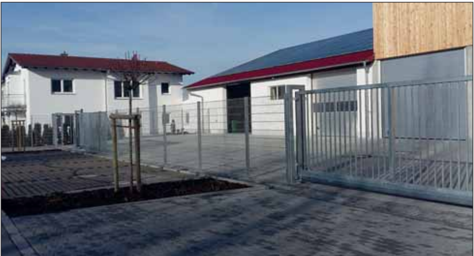
Neuer Bauhof. Foto: Markus Senger
