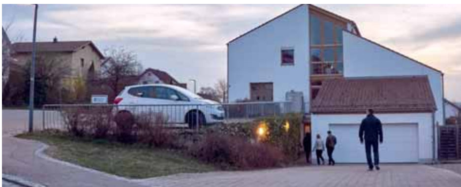
Das komplette Untergeschoss des Gebäudes an der Flurstraße wird derzeit für die Unterbringung des Kinderhortes umgebaut.
